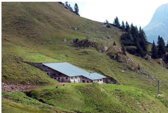
Almgebäude mit Pultdach als Lawinenschutz auf der Hirschgehrenalm in Warth (Vorarlberg).
